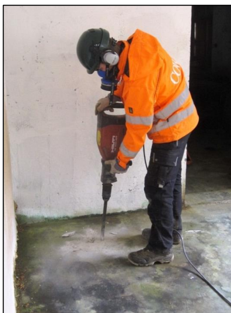
Figur 11. Provtagning i betonggolvet.
